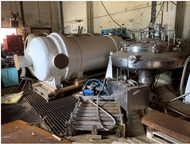
Figur 5-22: Verksted i oppredningsverk.
