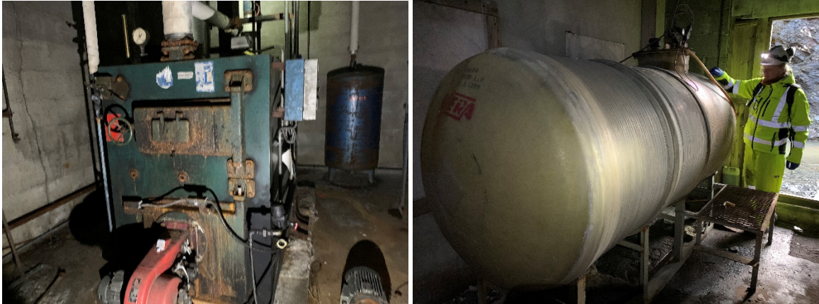
Figur 5-32: fyringsanlegg og oljetank ved inngang til hovedstoll.
