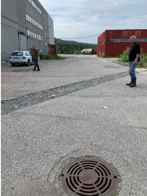
Figur 5-28: Kum utenfor hovedstoll. Vannet ledes videre i retning mot siloen i bildet, og sannsynligvis til slamdam.
