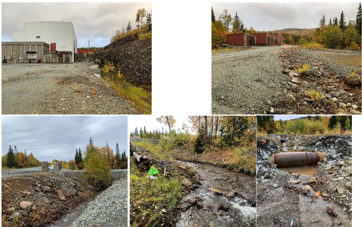
Figur 4-11: Øverst, fra venstre: Sig langs oppredningsverk (prøve ØHV_bekk4_MC), sig som mottar avrenning fra bl.a. smørebua og arealene bak denne (prøve ØHV_sig_MC). Sigene renner til prøvepunkt ØHV_bekk3_MC i Tippbekken. Nederst, fra venstre: Tippbekken som renner forbi tidligere lager for diverse utstyr og mellomlager for malm (prøve ØHV_bekk 3b_MC), Tippbekken nedstrøms lager (prøve ØHV_bekk 3a_MC), og Tippbekken like før den renner ut i Østre Hudningsvatn (prøve ØHV_bekk3_MC). Røret nederst til høyre ble etablert for å lede rene bekker nordøst for sjetéen.
