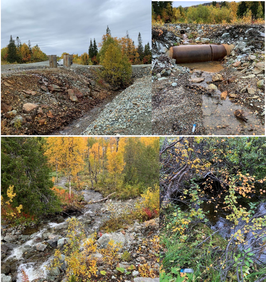
Figur 4-29: Øverst: Tippbekken som krysser vei i kulvert, og rør som krysser bekken like før utløp til Austre Hudningsvatnet. Nederst: Bekken som renner vest for gråbergtippen. Bekken krysser vei i kulvert, like før utløp i til Austre Hudningsvatnet.
