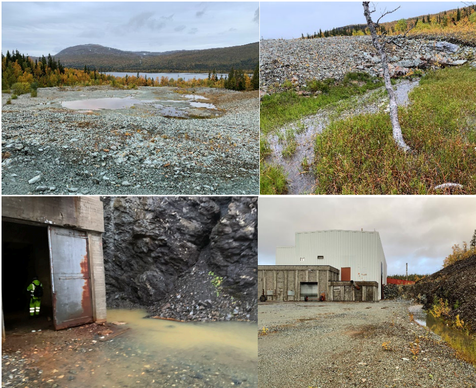
Figur 4-4: Eksempler på avrenning fra forurensede områder, til Austre Hudningsvatnet. Øverst: gråbergstipp og avrenning fra denne. Nederst: Forurensning fra under transportbånd og utenfor oppredningsverk, som ledes via bekk til Austre Hudningsvatnet.
