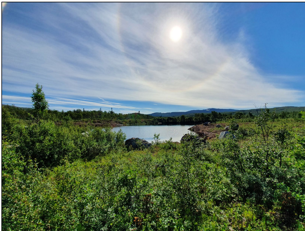
Figur 6-11 Dagbruddet er omgitt av kratt og tett vegetasjon som gjør det lite synlig i øyehøyde.
