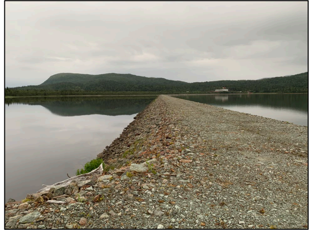
Figur 6-6 Industriområdet sett fra nordvest ved Sundtangen.
